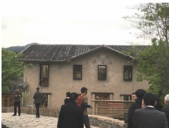
写真3 旧水力発電施設
